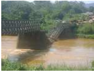
Figures.5 a,b et c : le Pont Ituri écroulé,déchargement de bois dans les pirogues et chargement dans les véhicules.
