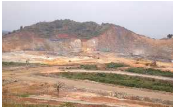
Des fouilles et chargements avec des engins lourds (Photo KGM)
