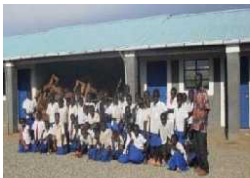
Une des écoles construites à Kokiza (Photo Kibali Gold Mines)
