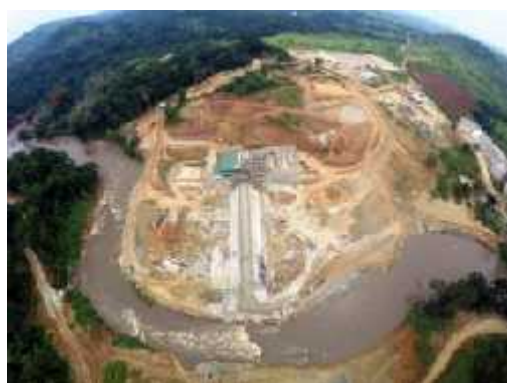
Construction des centrales hydroélectriques de Nzoro et de Ambarau (Photo KGM)
